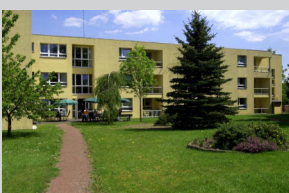
Anbau Altenpflegeheim Bad Münstereifel
