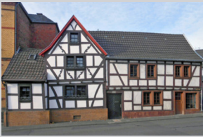
Denkmalgeschützte Hofanlage in Königswinter
