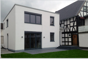
Erweiterungsneubau mit Teilsanierung
