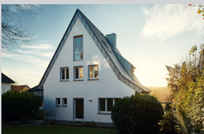
Dachausbau, Umbau und Sanierung
