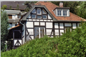
Umbau historisches Wohnhaus
